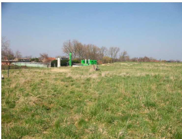
Afgedekte stortplaats (vóór de installatie van de zonnepanelen)
